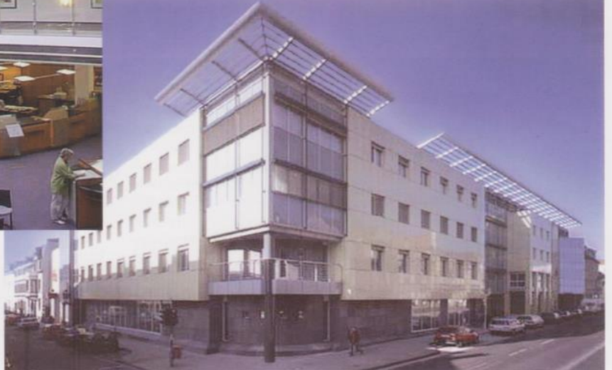
Ökologische Arbeitsbedingungen für Beschäftigte und Kunden: Dies war eine der Forderungen des Bauherrn im Rahmen des Umbaus und der Erweiterung des Sparkassengebäudes in Neuwied.
