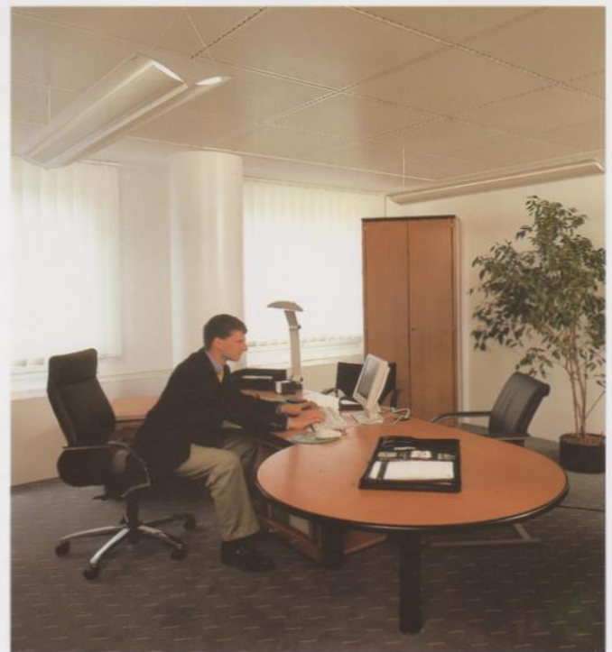
Unauffällige, aber komfortable Kühldeckensysteme und die Integration von indirekten Beleuchtungssystemen spielten eine wesentliche Rolle in der optischen Büro-Gestaltung.
